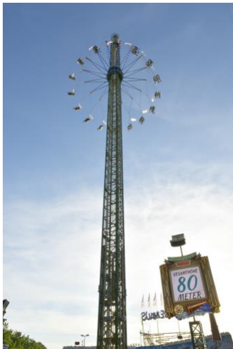
Besonders Mutige können sich im „Jules Verne Tower“ auf 80 Metern Höhe über den Dächern von Straubing an einem Drehstern durch die Luft wirbeln lassen. Foto: Fotowerbung Bernhard
